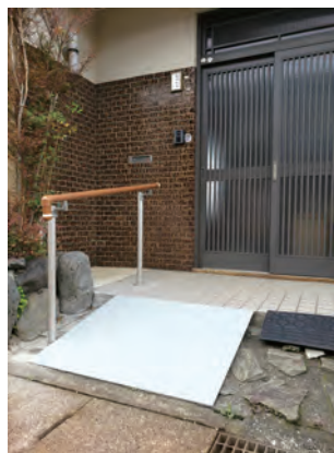
玄関ポーチに設置された 段差解消のためのスロープ
